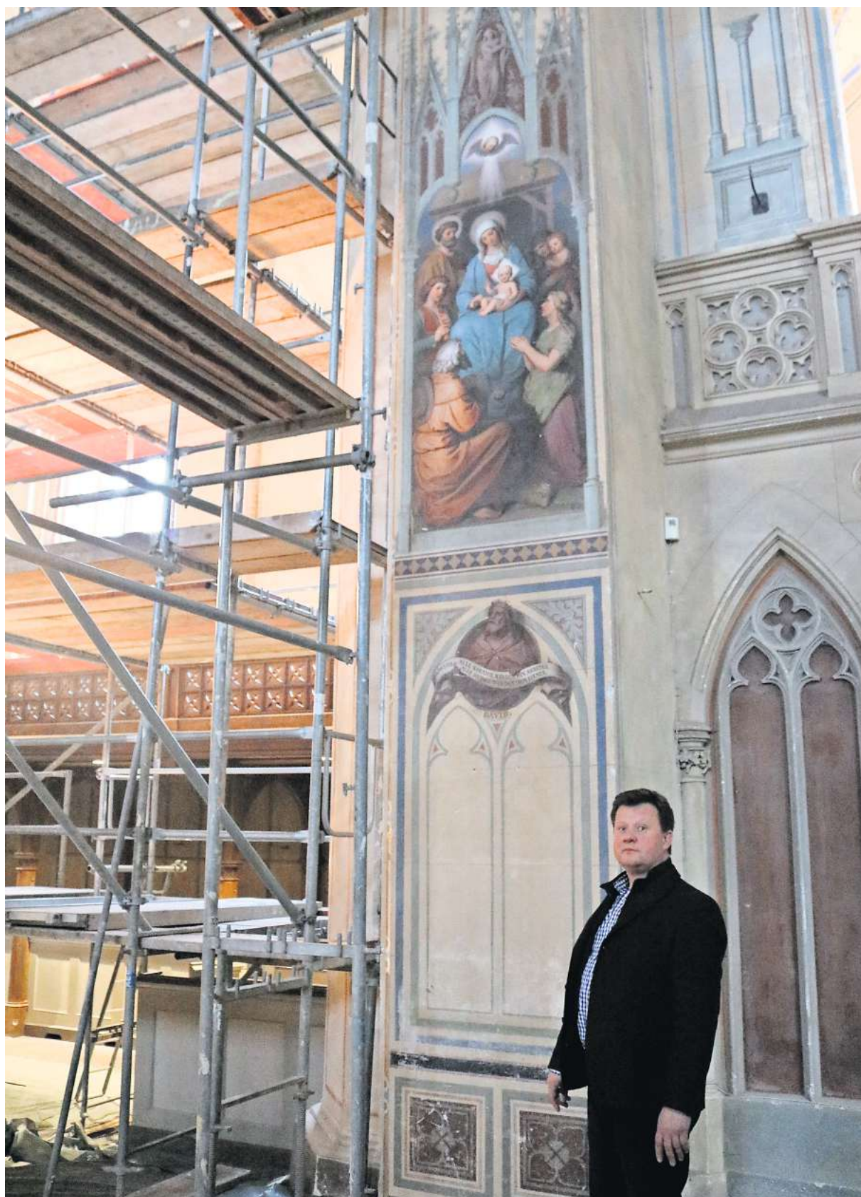
Die Marienkirche in Barth wird saniert und ihr Innenraum ist eingerüstet. Nur der Chorraum, in dem Pastor Stefan Fricke steht, ist noch frei.
