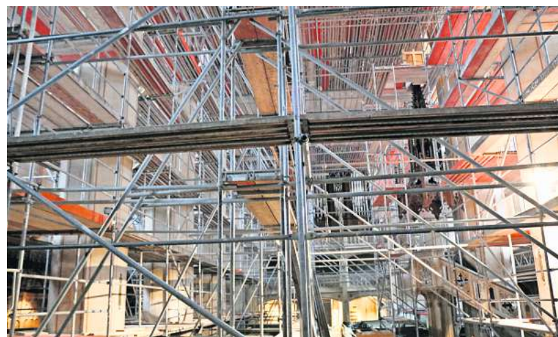
Unzählige Gerüststangen durchziehen die Marienkirche. Jede Stange ist von Hand hereingetragen worden.
